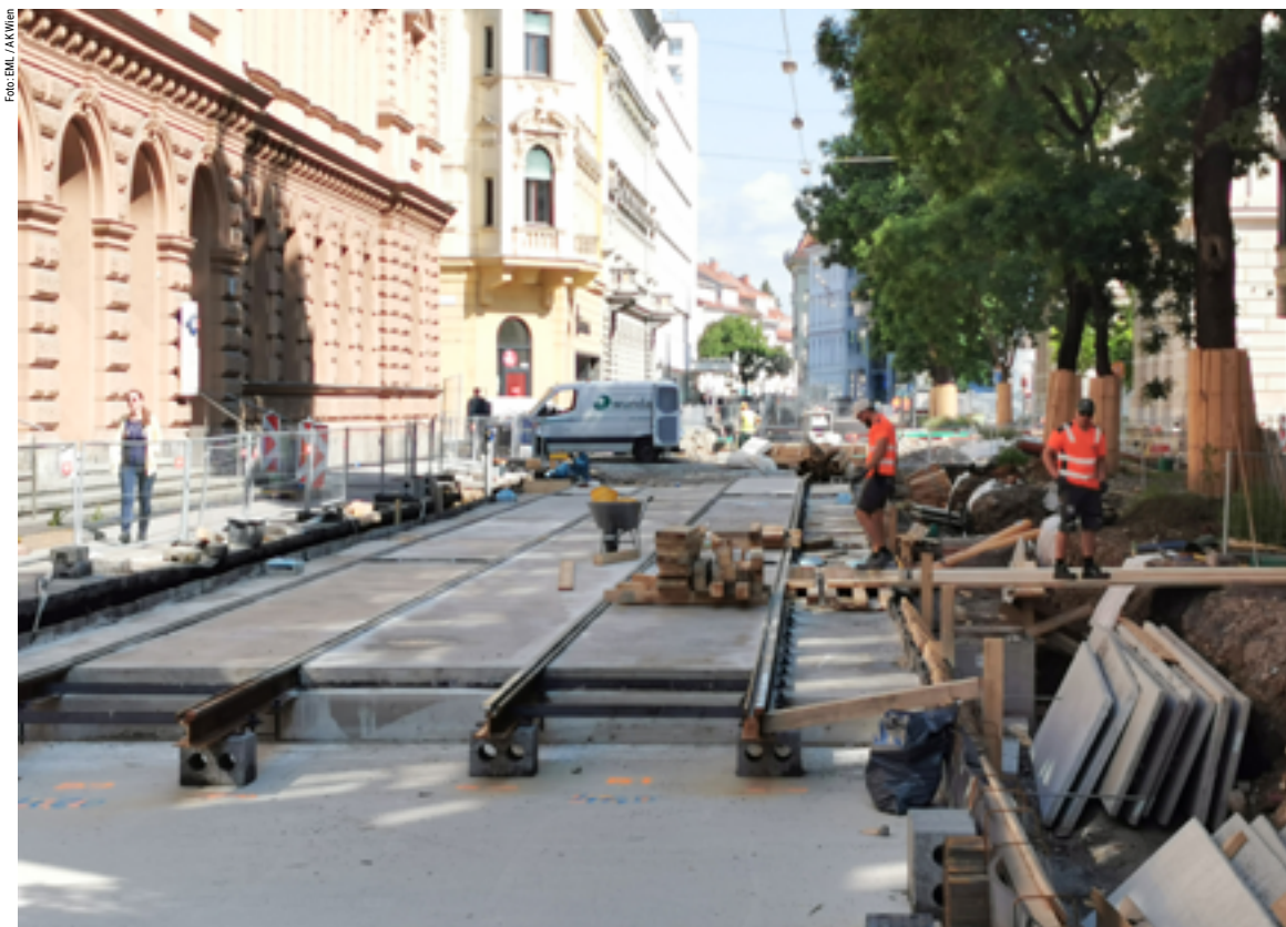
Auch der Straßenbahnbau soll durch verbindliche soziale und ökologische Kriterien mehr zum Klimaschutz beitragen.
