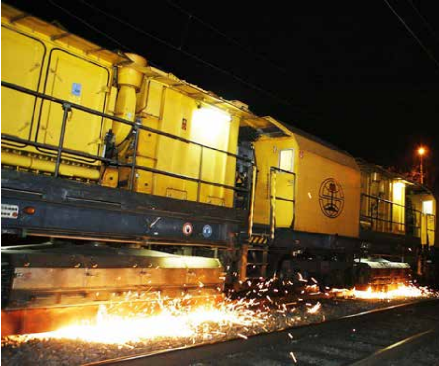
Regelmäßiges Schienenschleifen ist Lärmschutz an der Quelle.
